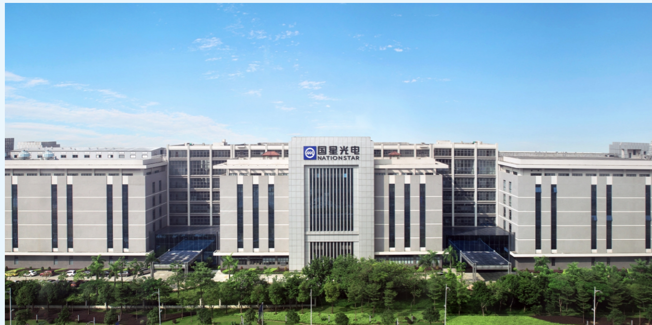
国星光电总部 佛山华宝厂区 公司总部, LED器件、LED组件生产基地 占地面积60,049.93平方米 建筑面积116,292.52平方米
